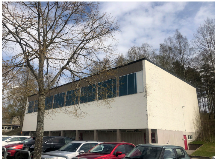
Befintlig idrottsbhall som finns på fastigheten Lundby 1:1.
