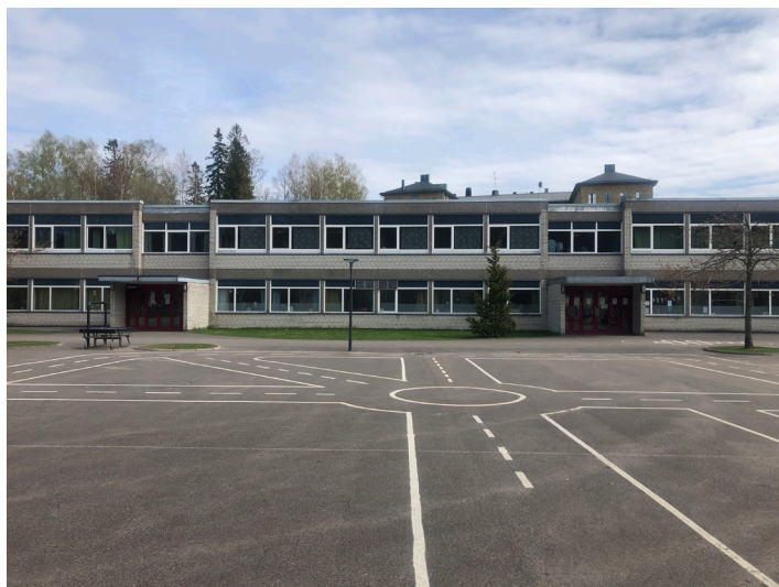
Befintlig skolbyggnad som finns på fastigheten Lundby 1:1.
